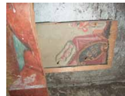
Bruneck, Boden im Souterrain einer Jugendstilvilla: Ausflickung im abgetretenen Bereich, Fotoarchiv T. Rekelhof
