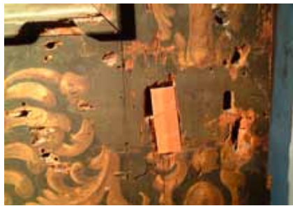
Lienz, Schloss Bruck, Nordfassade: statische Sicherung durch Unterpöhlung, Fotoarchiv Markus Pescoller
